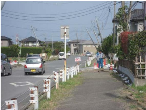
宅地地盤全体のひずみ ⇒ 電柱の傾斜、道路の変形
